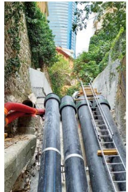
Die PE-Leitung zum weiteren Transport der Wärme-/Kälteenergie
